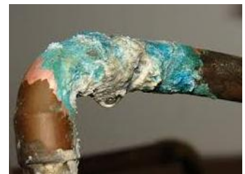
أنابيب نقل المياه
